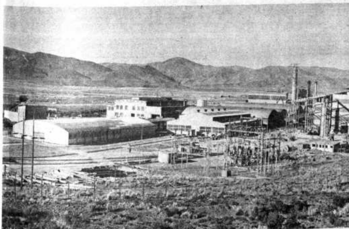
La pequeña ampliación de la Fundición de Estaño de Vinto, permitirá incrementar su actual producción de 7.500 TMF/Año, a 11.500, como un paso a su total capacidad de 20.000 TMF/Año que está en plena ejecución.
