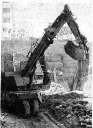
Edificio "La Primera" 22 pisos; trabajos de excavación para fundaciones.
