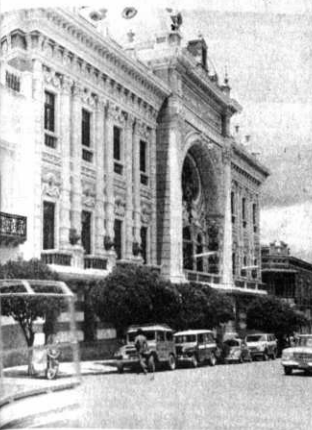
"En el orden vial, el Departamento de Chuquisaca cuenta con un solo kilómetro de carretera asfaltada y apenas dispone de un camino cementado al aeropuerto. En tiempo de lluvias, la capital queda totalmente aislada del resto del país y no se puede llegar a ella, ni por tierra ni por aire. Queda igualmente interrumpida su comunicación con las provincias".
