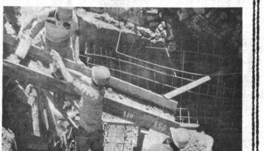
Obreros de la empresa SEBOL Ltda. en plena actividad cuando hormigonan la base de entrada del túnel. La longitud de este túnel es de 300 mts.
