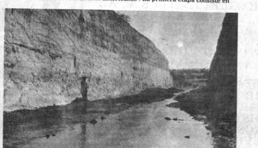
Otra de las obras que en este momento está realizando la Asociación San Jacinto es el desvío de la quebrada seca.
