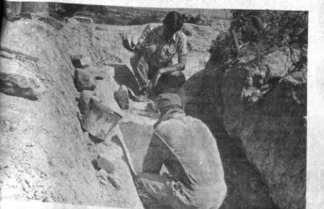
El camino de acceso a la presa y casa de máquinas está prácticamente concluído, faltando tan sólo la capa base. En la fotografía, un ingeniero de San Jacinto supervisa los trabajos que se realizan.
